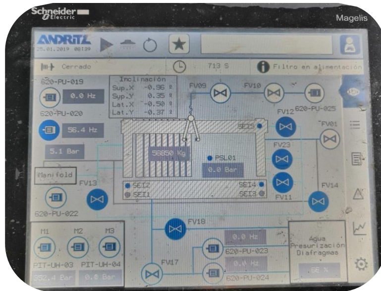
Figura 3.6 Interfaz de usuario del Filtro Prensa de relave Andritz modelo 2500 Fuente: Cesar Miranda. Visita a planta de procesamiento de mineral [31]
